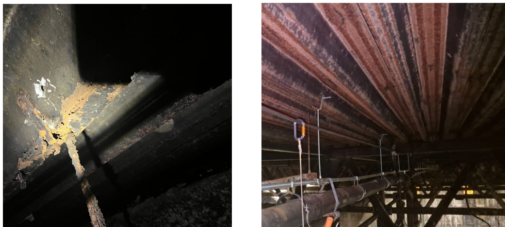
54 pav. Vaizdai iš 2025 m. rugsėjo–spalio mėn. aukštalipių fotonuotraukų: surūdiję laikikliai inžinerinėms sistemoms tvirtinti, plieninio profiliuotojo pakloto labiausiai yra aprūdijęs horizontalusis paviršius su standumo grioveliais
