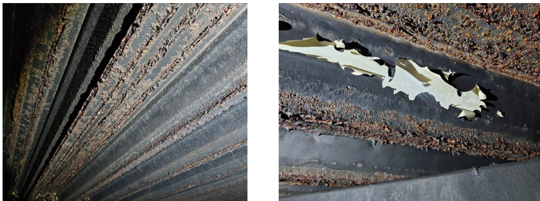
81 pav. Profiliuotojo pakloto plieno skardos ištisinė korozija, plečiasi linijomis, 17-oje tyrimų vietoje
