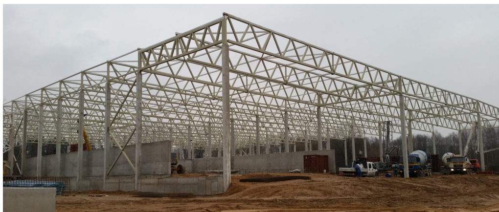
17 pav. Statinio plieninių konstrukcijų montavimas, 2014 m. gruodžio 16 d.
