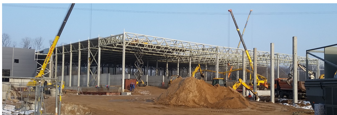
18 pav. Statinio plieninių konstrukcijų montavimas, 2015 m. vasario 4 d.
