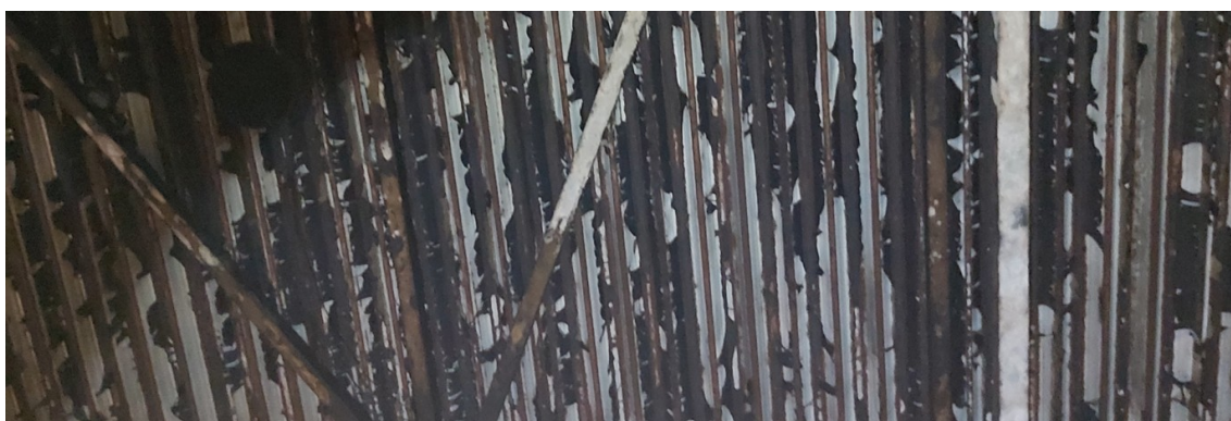
15 pav. Stogo plieninio profiliuotojo pakloto paviršiaus bendrasis vaizdas: nusilupę dažai; rūdijimo paveikti ruožai. 2025 m. spalio 14 d.
