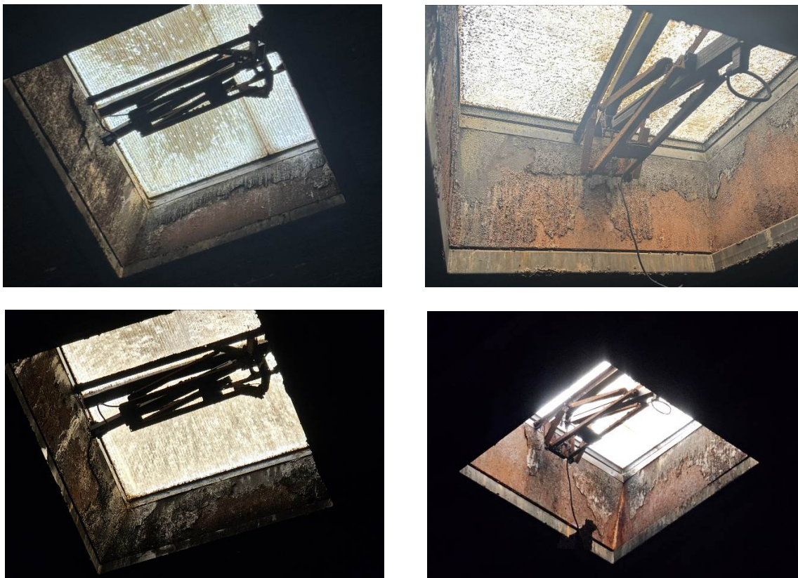
91 pav. Paveikti korozijos stoglangių tvirtinimo karkasai
