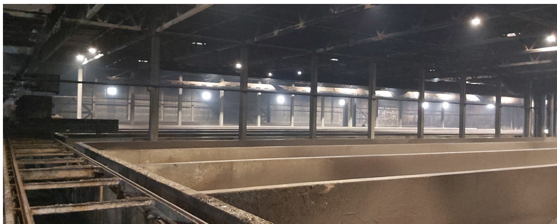
11 pav. Pagrindinės patalpos atliekų apdorojimo užpildytų „tranšėjų“ ir stogo konstrukcijų bendrasis įstrižas vaizdas nuo ašių „19“ ir „2P“ sankirtos, 2025 m. spalio 14 d.
