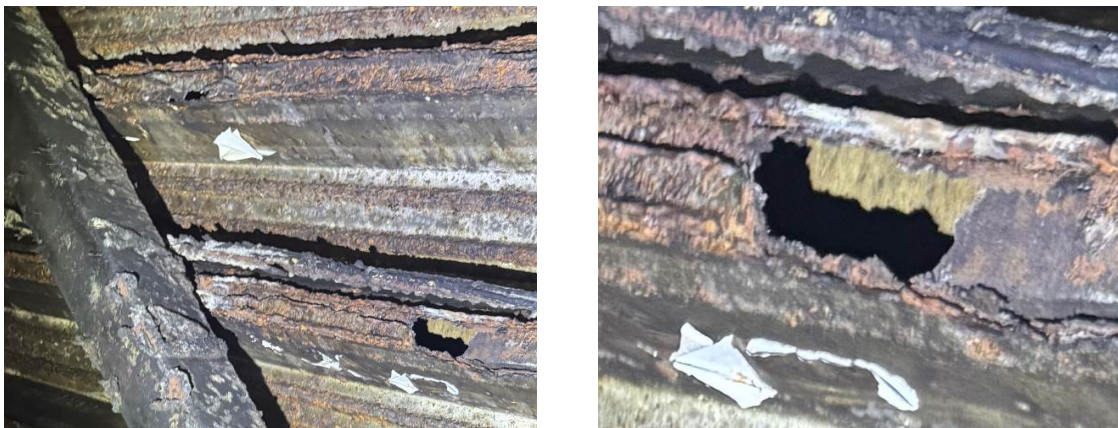
86 pav. Profiliuotojo pakloto skardos lakštų kiaurymės 5-oje tyrimų vietoje
